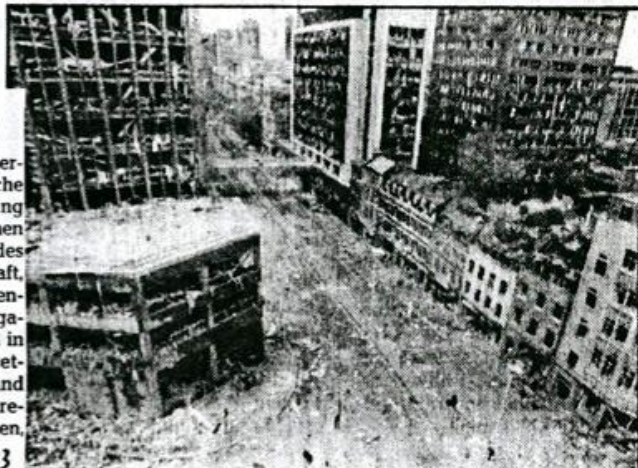
Bild der Verwüstung: Bei dem gewaltigen Bombenanschlag in Londons Innenstadt entstand Sachschaden in Milliarden-Höhe.
